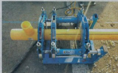
PE가스관 버트용착 기준표의 가압용융압력범위가 너무 넓어 개정이 필요하다는 주장이 제기되고 있다. (사진은 화천군 LPG배관망사업현장에서 PE관을 용착하는 모습)
